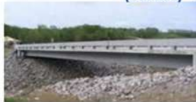
Mars hill bridge (USA)-2004
